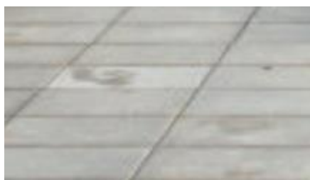
Fliser lagt i 0-forbandt
